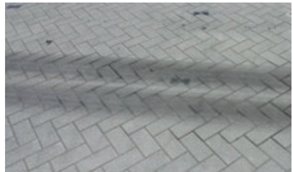
대일텍 3D-HOLE블록 시공사진
